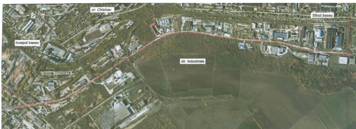
FIGURA 156. STRADA INDUSTRIALĂ - CHIŞINĂU
