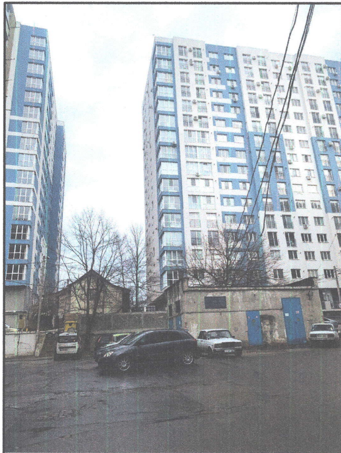
CLADIRI LOCATIVE MULTIFAMILIALE (16 NIVELE) SITUATE IN ZONA DE ACTIUNE CODULUI DE REGLEMENTARE URBANISTICA C2
