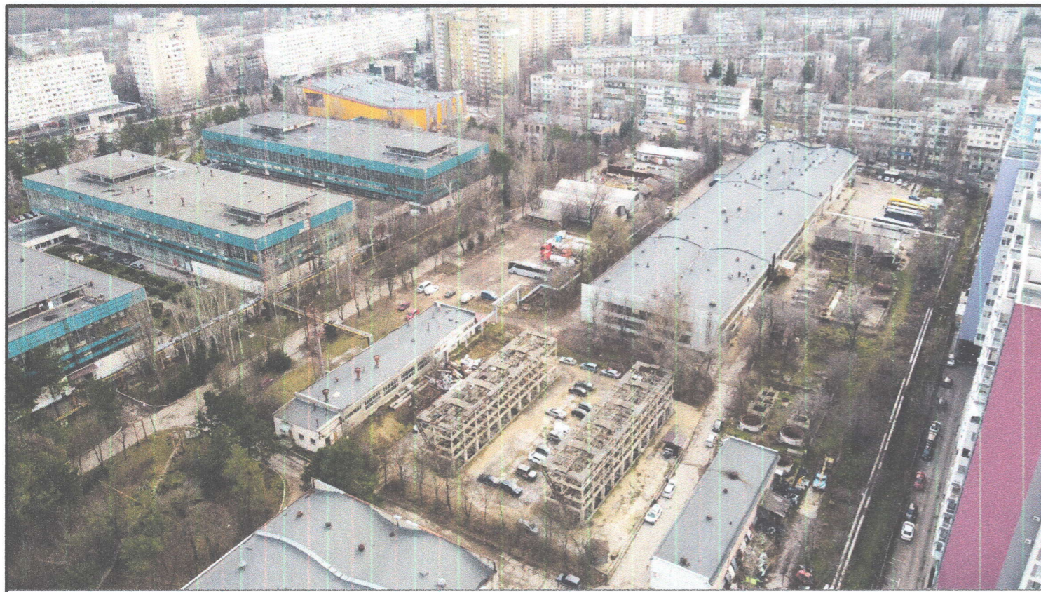
FONDUL CONSTRUIT. TERENUL CU NR./C. 0100413.226. VEDEREA DIN PARTEA STR.STUDENTILOR
