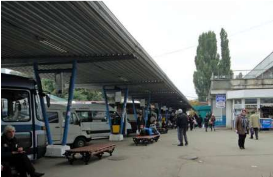
Figura 29: Stația de autobuz centrală din Chișinău
