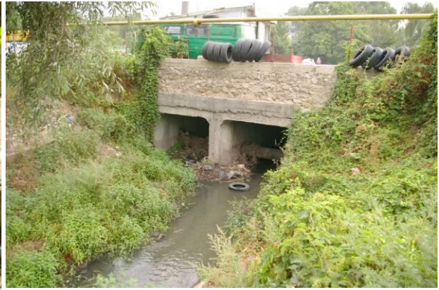
Figura 33 R-ul Valea Trandafirilor la intrare sub str. Calea Moșilor
