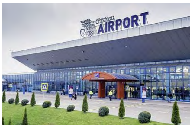
FIGURA 234. CENTRE DE TRANSFER EXISTENTE
